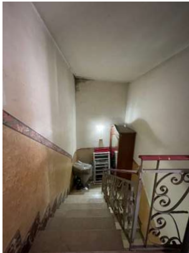
Vano scala dell'edificio
