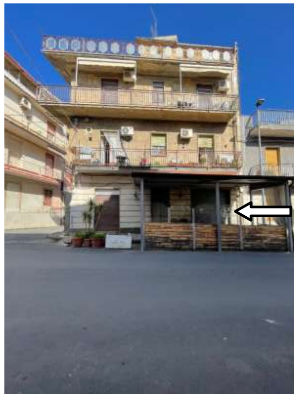
Prospetto sud del bar, indicato con freccia
