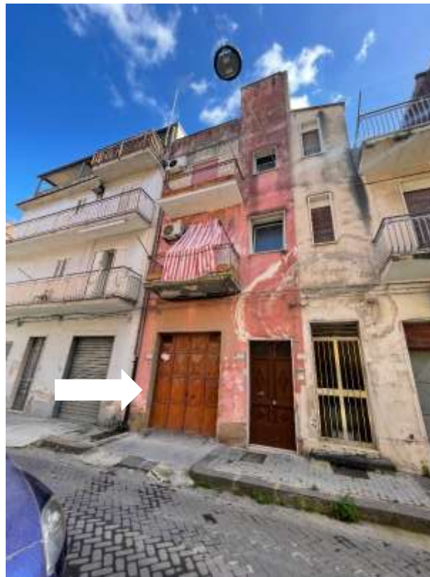
Prospetto ovest dell'edificio in cui è il garage indicato con freccia
