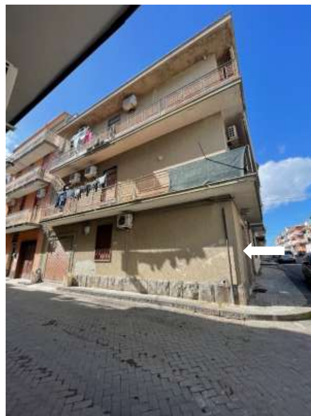
Prospetti nord ed est del magazzino al piano terra, indicato con freccia
